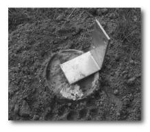
Mit Schnellbinder betonieren Sie bitte eine Gründung nach der anderen! Beginnen Sie dabei mit der höchstgelegenen Gründung und richten dazu alle anderen waagerecht aus. Zunächst wird der Beton mit der passenden Menge Wasser nach und nach in die Ausschachtung zu 2/3 eingefüllt und verdichtet (z.B. mit einem Kantholz). Anschließend kann das Rohr eingesetzt und lot- und fluchtgerecht sowie in der für Ihr Grundstück passenden Höhe ausgerichtet werden.
